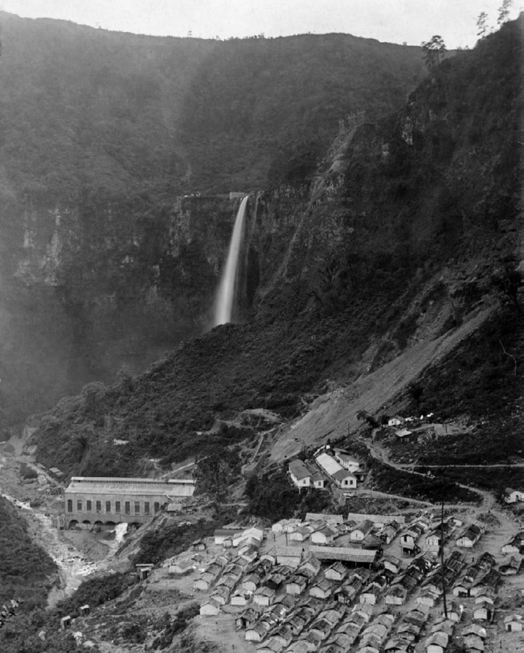
Figura 33. Hidroeléctrica de Necaxa, propiedad de la Mexican Light and Power Co. Se aprecia la caída de agua que alimenta las turbinas de la planta generadora de energía, que sería la encargada de surtir parte del centro del país y, en el tema que nos ocupa, a la subestación eléctrica de Pueblo Nuevo que transformaba el voltaje que recibía y lo repartía entre las minas y las poblaciones cercanas 1905.
